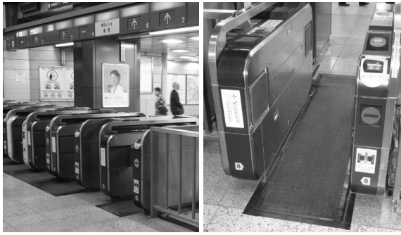
Рис. 7. Система накопичувачів енергії на основі ПГ, вмонтованих у настил підлоги на вході станції метро Marunouchi (Токіо)
